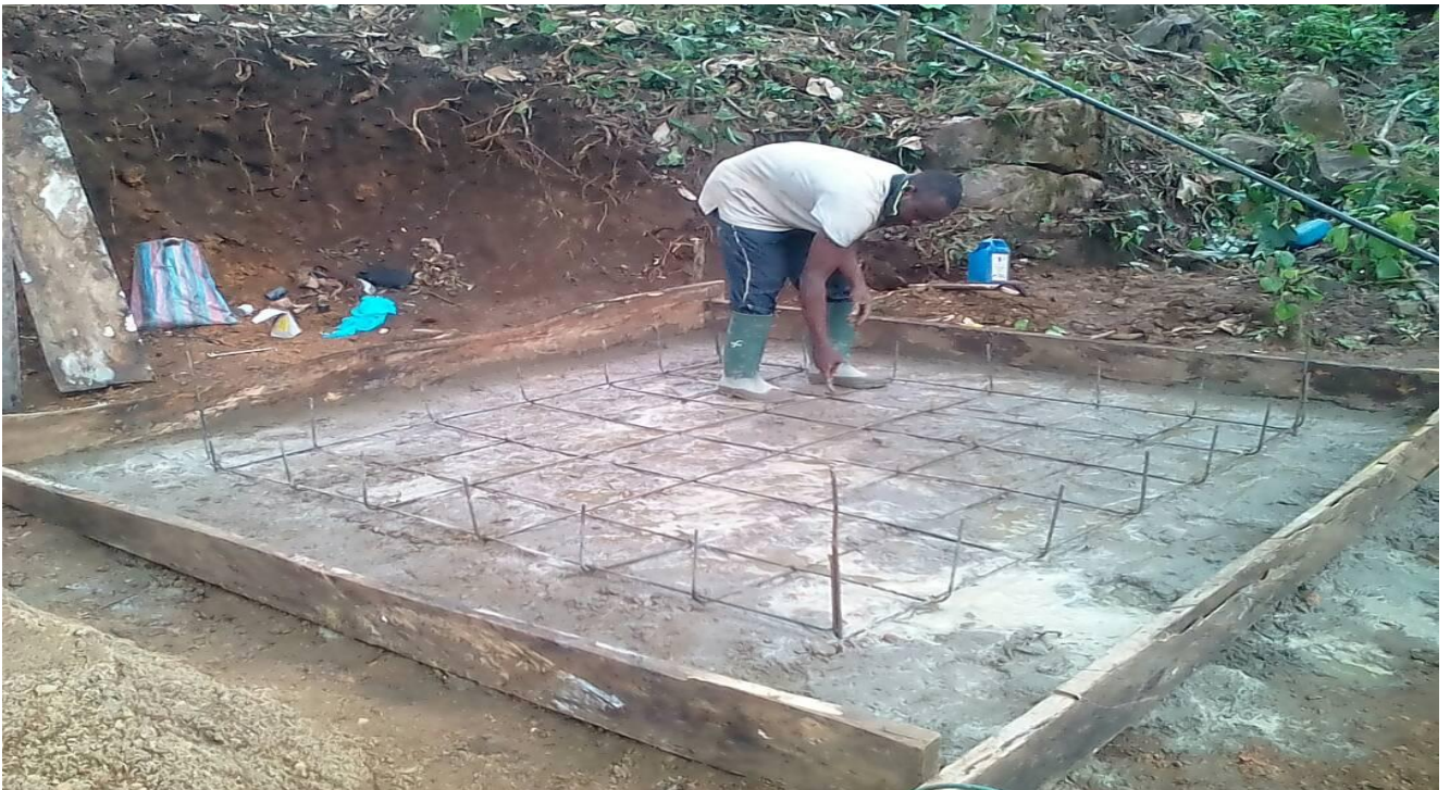
Fundament des Wassertanks
