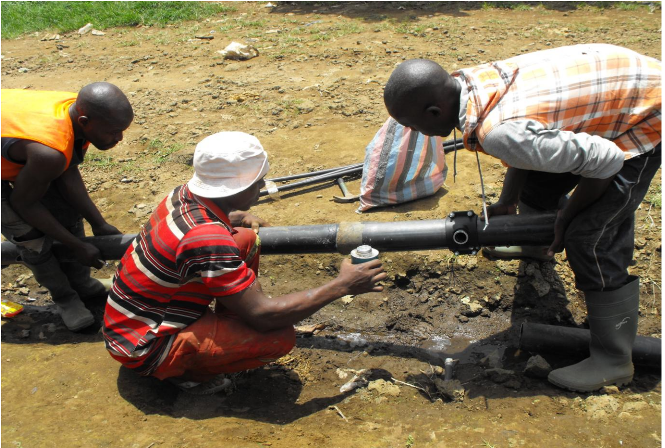
Wasserrohre Verlegung
