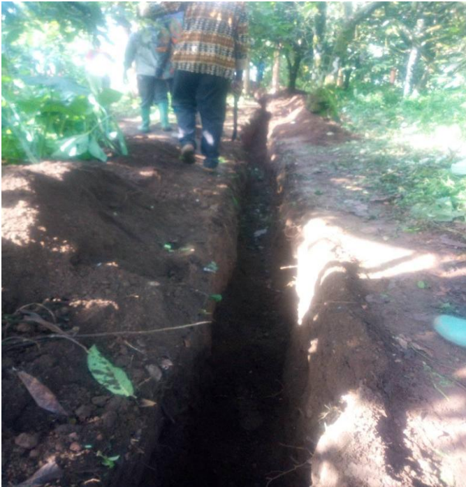
Gräben für die Wasserrohre graben ohne Maschine
