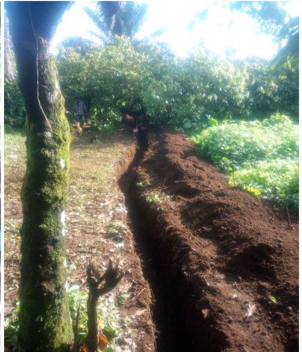
Gräben für die Wasserrohre graben ohne Maschine
