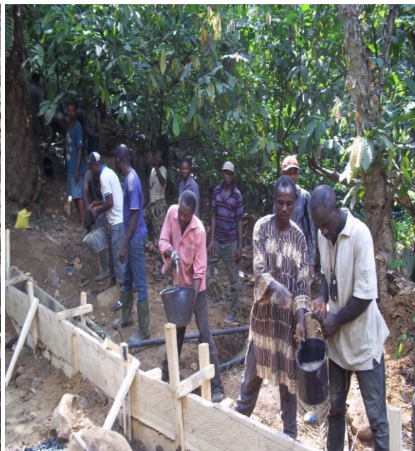
Grundmauer von Wasserquelle wird durch Kommunalarbeit gebaut länger von mehr als 20m weiter als vorgeplant. Bei der Säuberung der Wasserquelle merkt man dass die Quelle breiter war.
