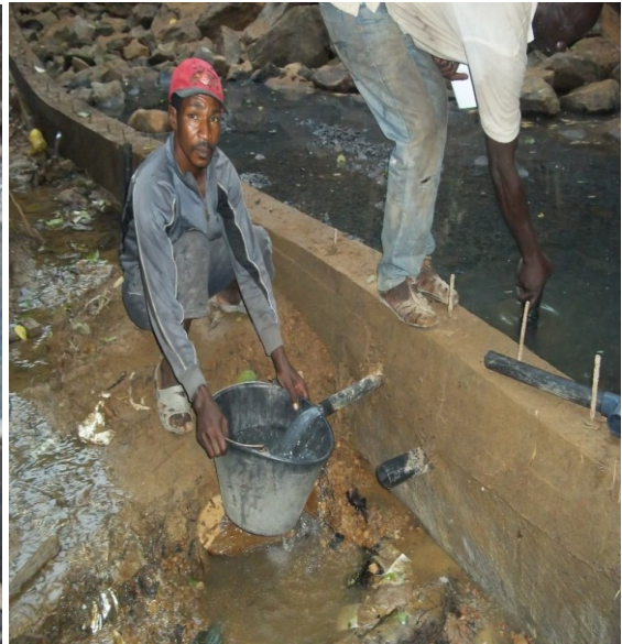
Einen Damm ist gebaut um das Quellewasser ein zu sammeln
