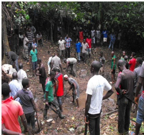
Bauanfang Ende Dezember Wasserquelle
