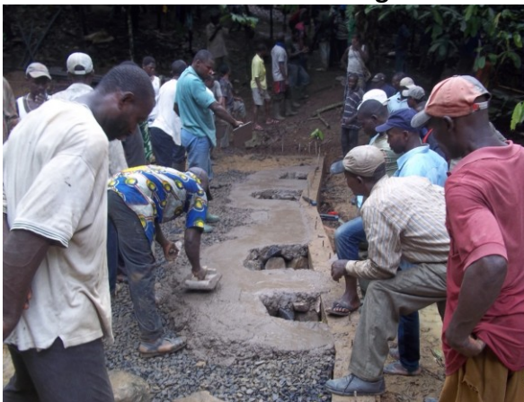
Die Wasserquelle wurde betoniert nachdem die Filtrierungsschichtung untergelegt sind.
