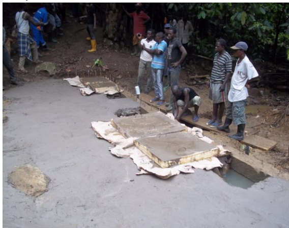
Die Wasserquelle wurde betoniert nachdem die Filtrierungsschichtung untergelegt sind.
