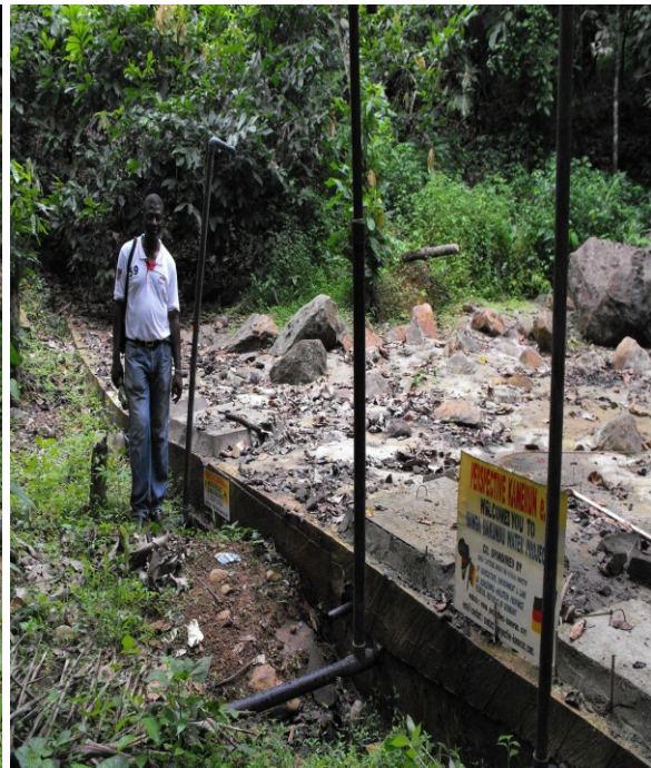
Die Wasserquelle zeigt die Ausgangröhre zu Wassertank und Luftröhren nach dem Bau
