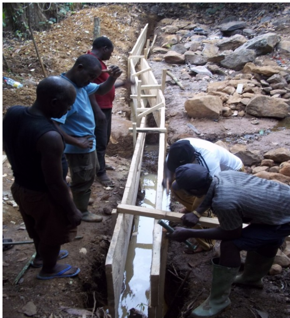
Grundmauer von Wasserquelle wird durch Kommunalarbeit gebaut länger von mehr als 20m weiter als vorgeplant. Bei der Säuberung der Wasserquelle merkt man dass die Quelle breiter war.
