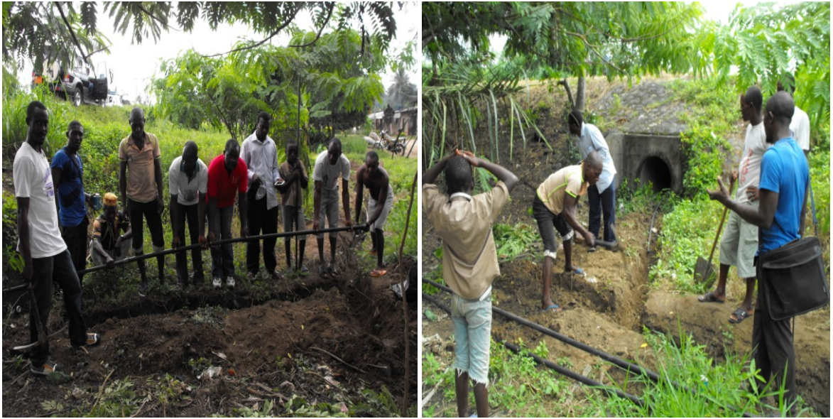
Die Wasserleitung wird durch Strassentunnel verlegt um die Hähne zu verbinden.
