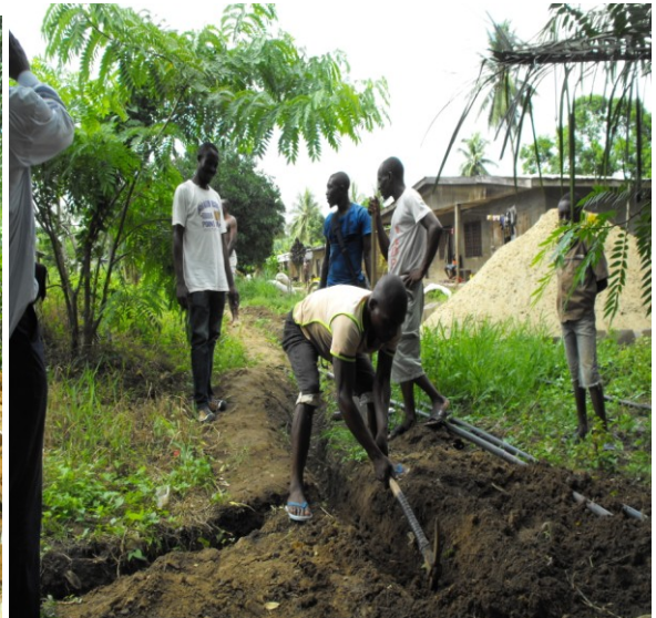
Die Wasserröhren werden begraben
