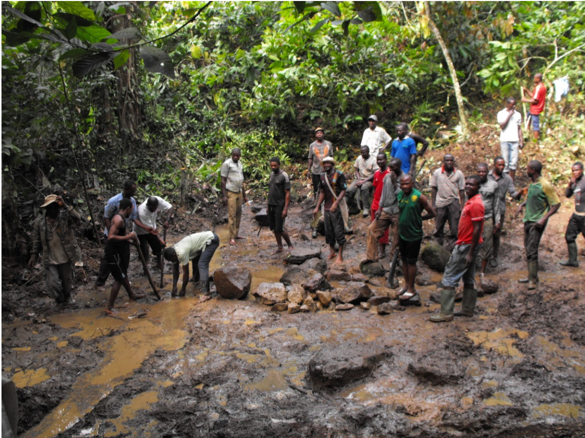
Die Wasserquelle wird gereinigt Ende Dezember 2014
