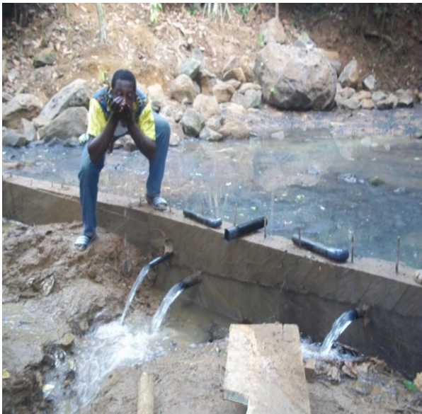
Einen Damm ist gebaut um das Quellewasser ein zu sammeln
