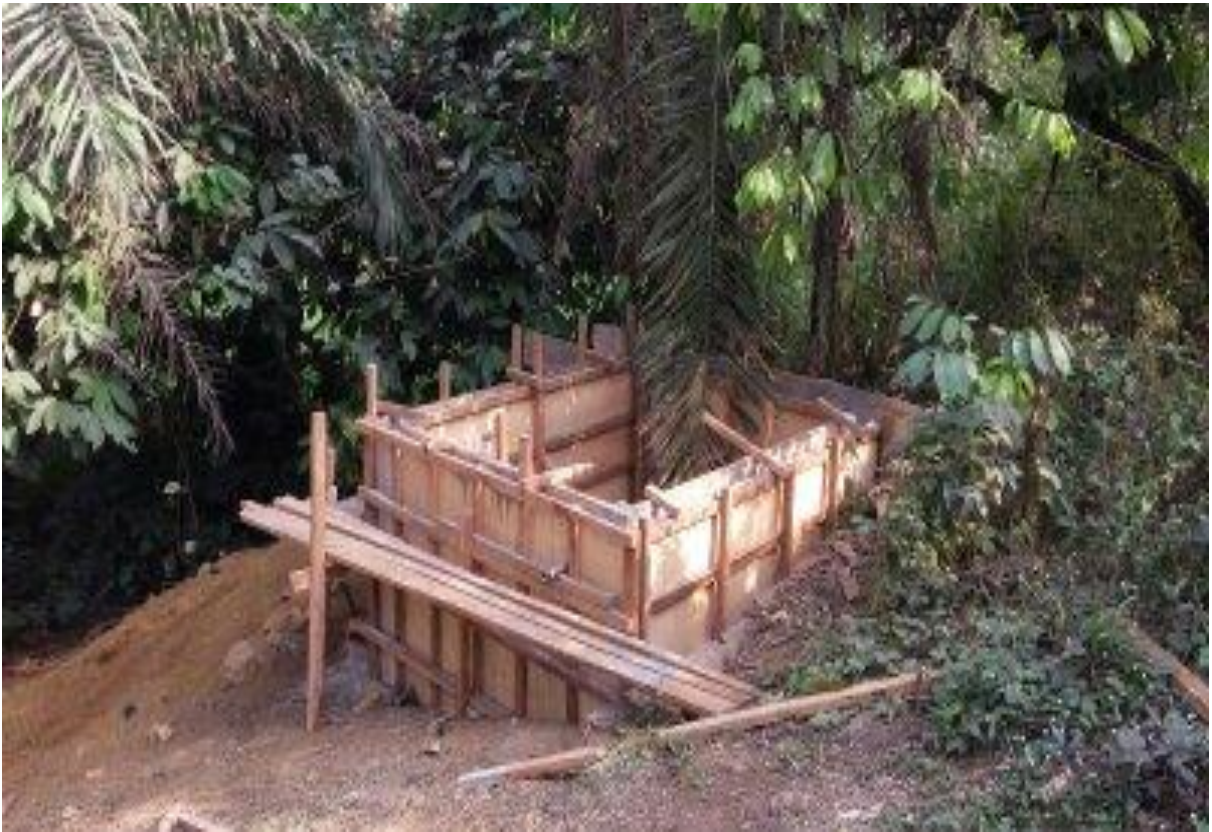
Konstruktion von Wassertank
