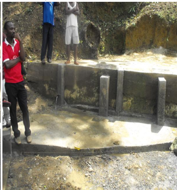
Fertige Wasserquelle von Mother water mit Beton Laufweg und überfluß Rohren.
