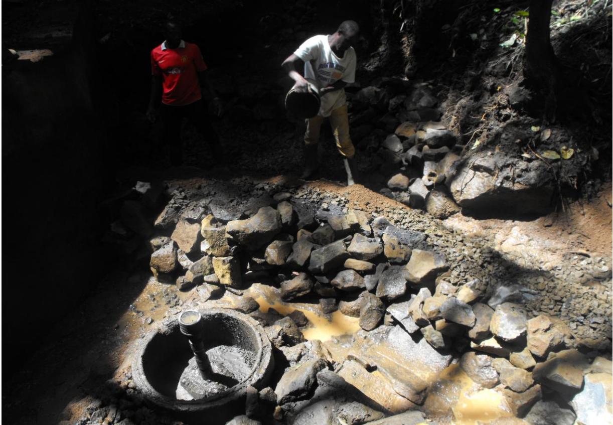
Bauarbeit bei der Wasserquelle
