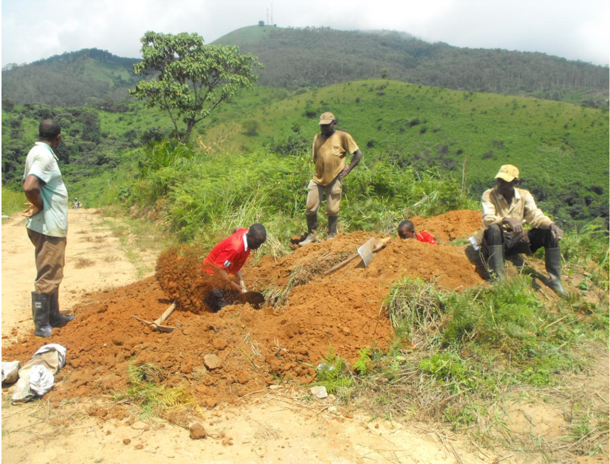
Begraben der Trinwasserleitung im Dorf
