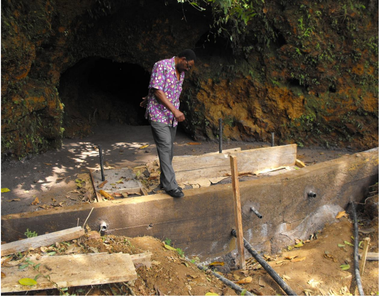
Die Waaerquelle is betoniert, das Wasser ist filtriert und fliesst durch PVC-Rohr.
