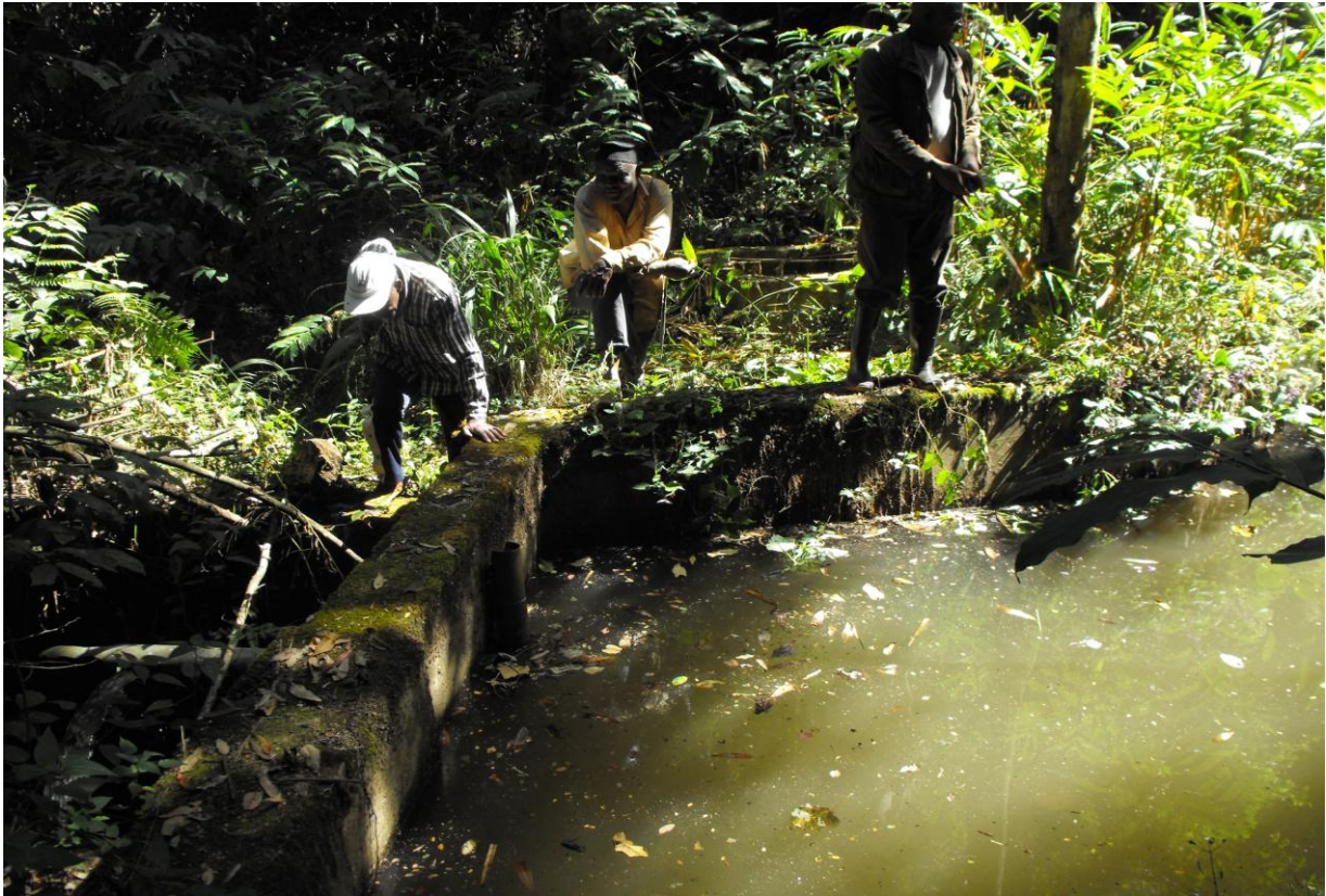
Quellwasser wie gefunden in Batack-Babouantuo vor Baubeginn in Dezember 2015
