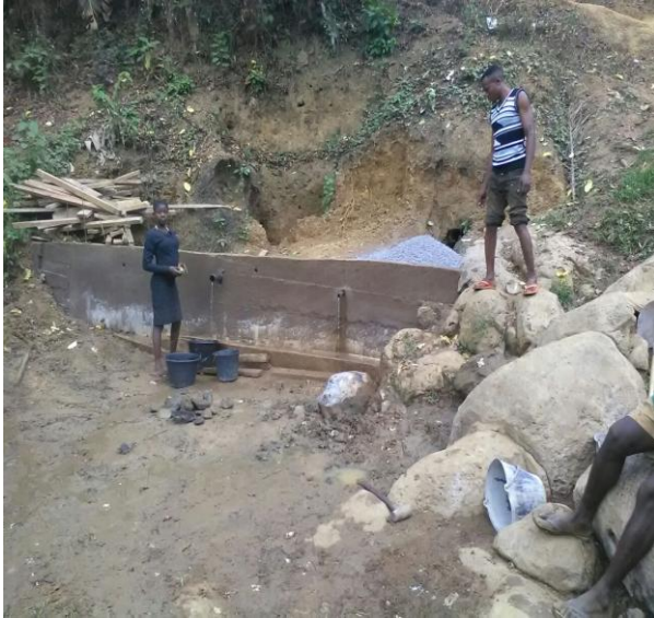
Konstruktion des Filtersystem der Wasserquelle
