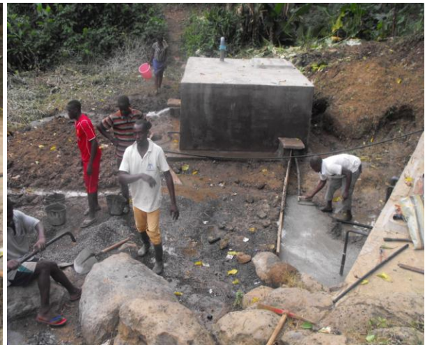
Betonierung de PVC-Rohre um zu Schützen von Quelle zum Wassertank.
