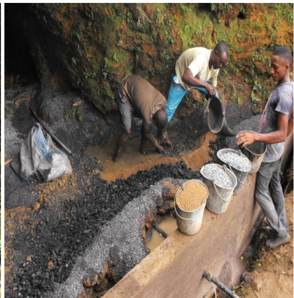
Verlegung der Filtrierungsschichten
