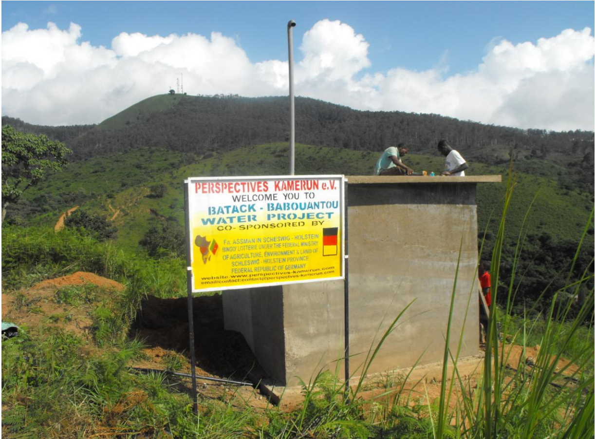
Wassertank und Hinweisschild in Bataack-Babouantou
