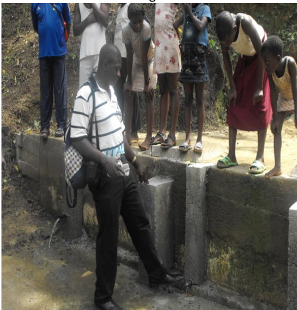
Fertige Wasserquelle von Mother water mit Beton Laufweg und überfluß Rohren.
