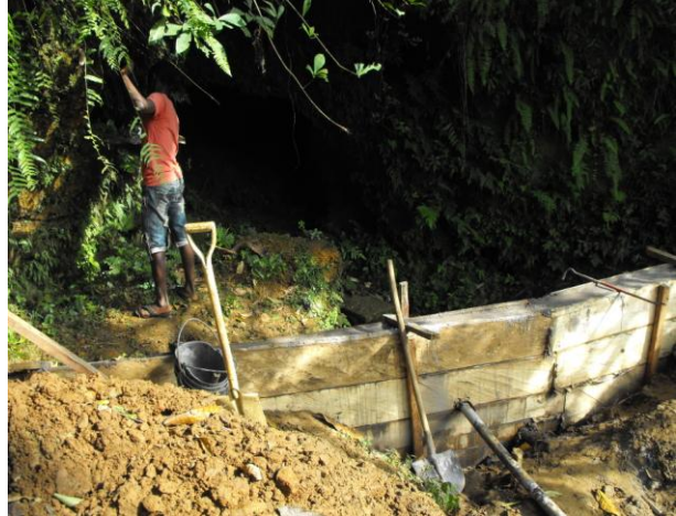
Betonmauer um Quellwasser zu blokieren
