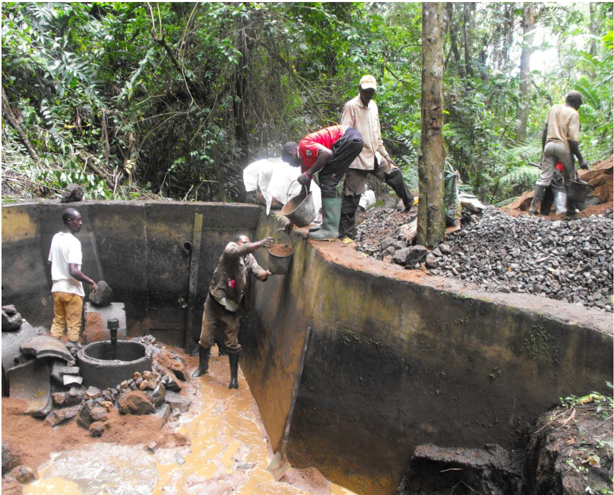
Die Bauarbeit geht weiter
