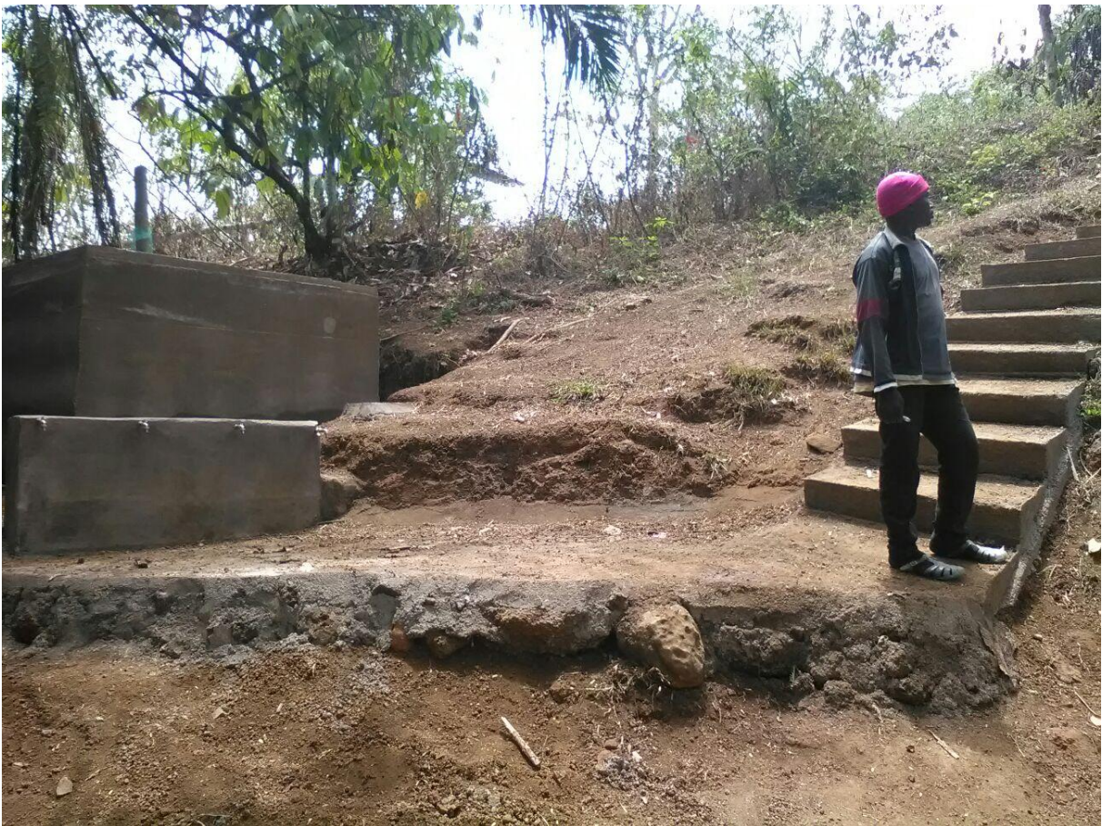
Bauwerke aus Beton. Wassertank, Trinkwasserzapfstelle und Treppen aus Beton
