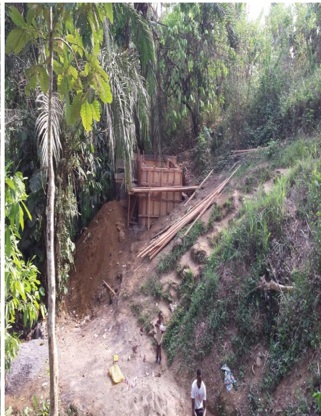
Konstruktion von Qaaerquelle und Betontreppe
