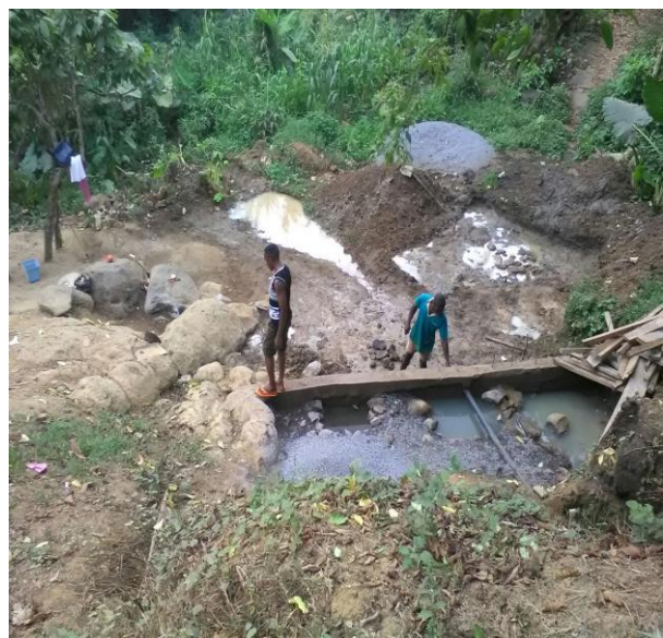
Bau der Wasserquelle
