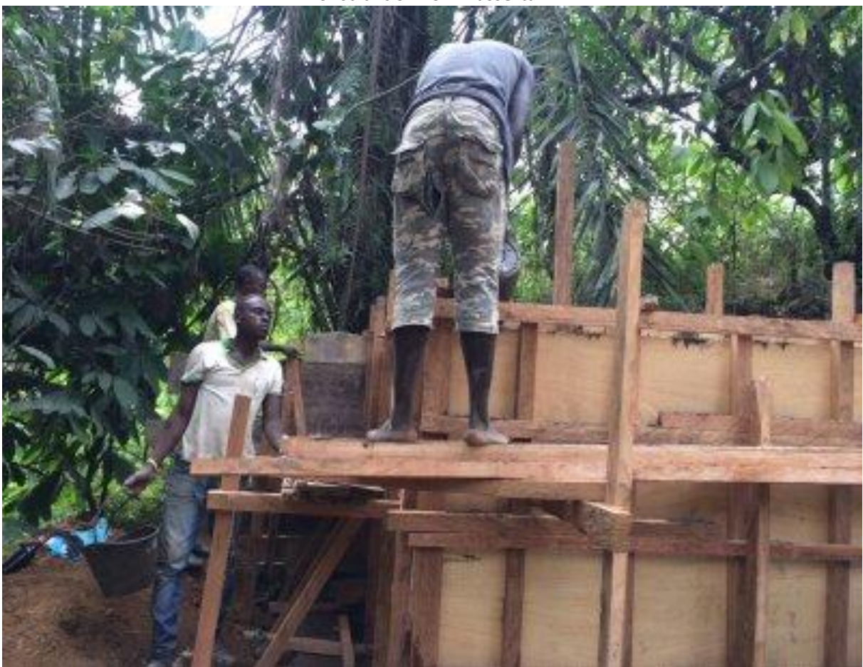
Konstruktion von Wasserundurchlässige Bauwerke aus Beton
