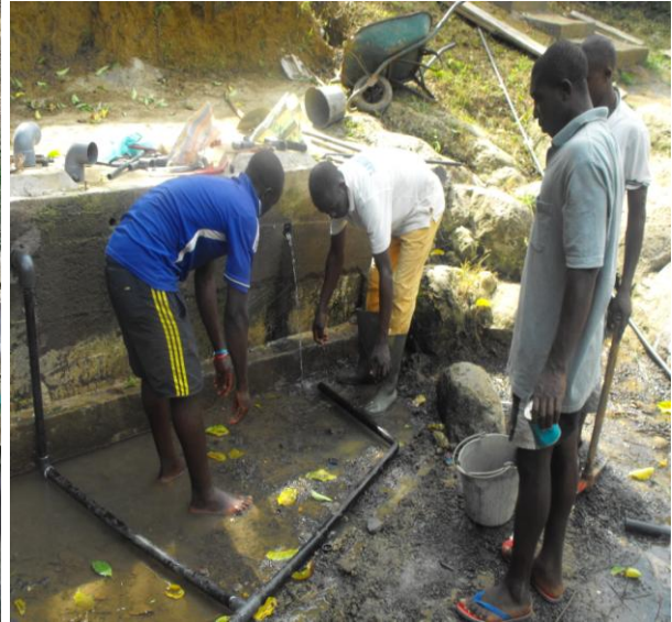
Konstruktion des Filtersystem der Wasserquelle
