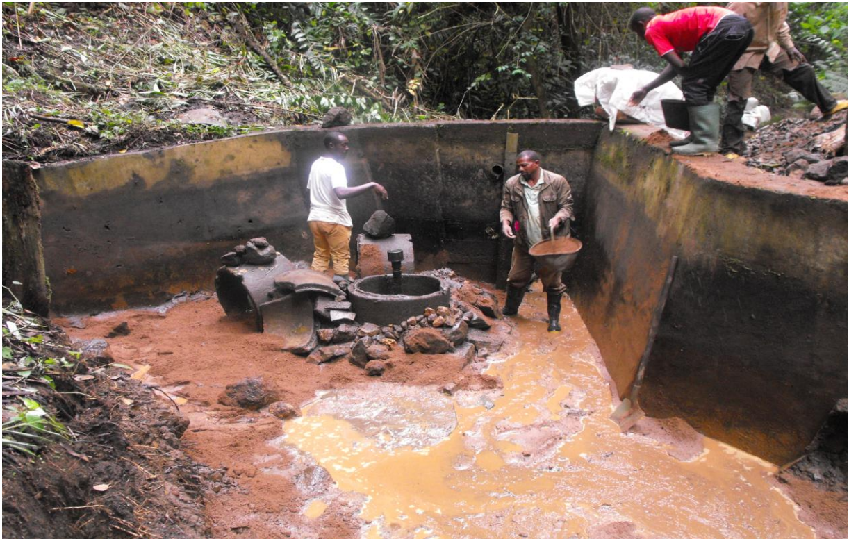
Reinigung de Wasserquelle und Bau der Filtrierungsschichten mit Kies, Sand, Kohle.
