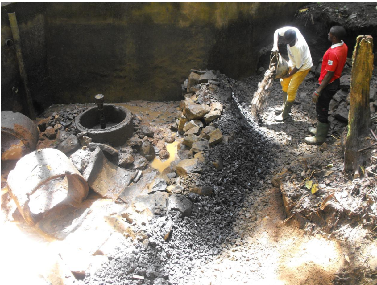
Bau der Filtrierungsschichten
