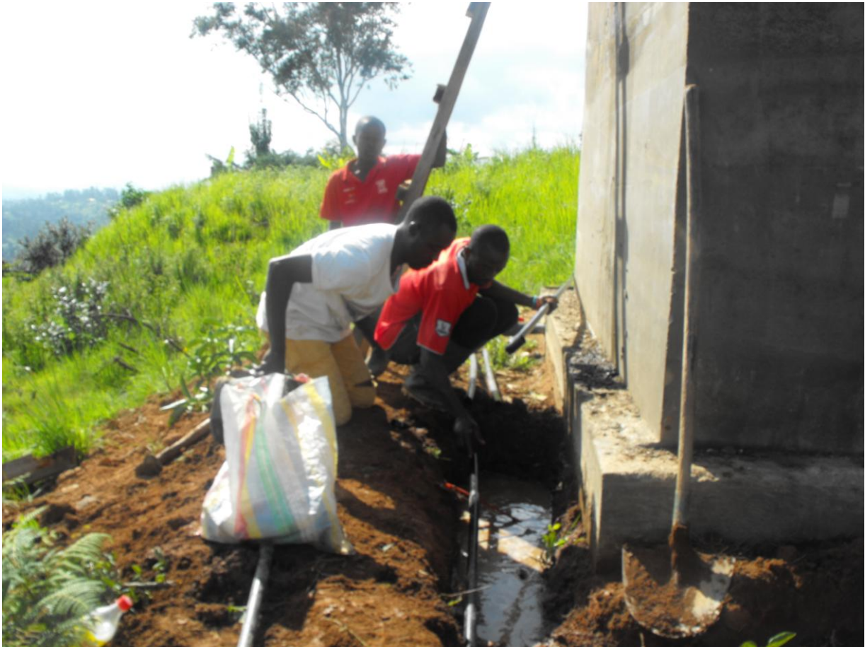
PVC-Rohr Verlegung zwischen Wasserquelle und Wassertank.
