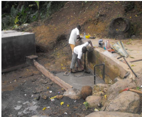
Betonierung de PVC-Rohre um zu Schützen von Quelle zum Wassertank.
