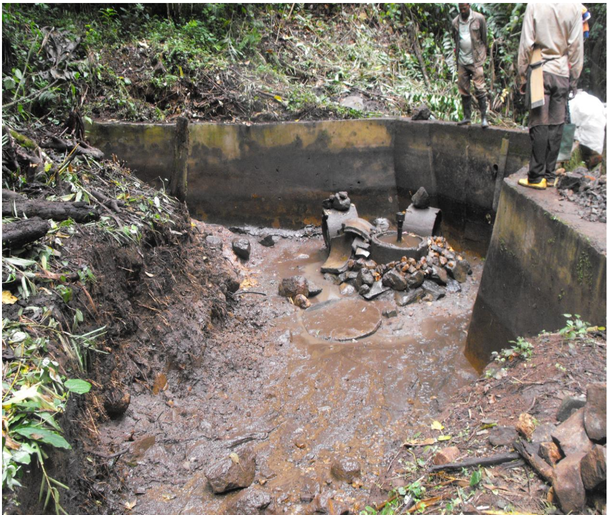
Betonmauer der Wasserquelle bevor der Filtrierungsbau in Bataack-Babouantou.
