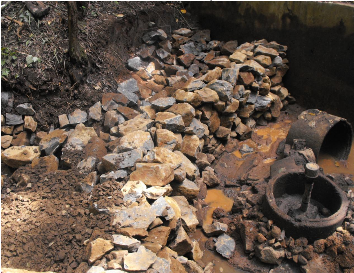
Bau von Filtrierungsschichtung
