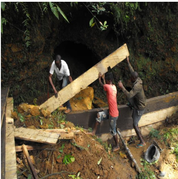
Entfernung von Holzplatten
