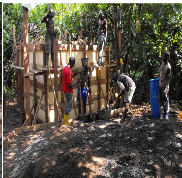
Wassertank Betonierung
