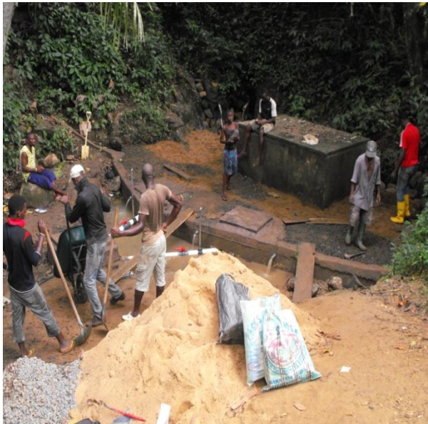
Wasserquelle Betonierung.
