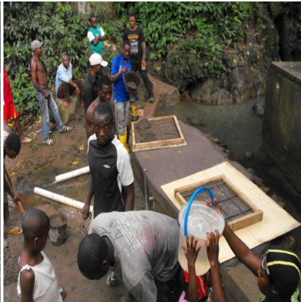
Wasserquelle Betonierung
