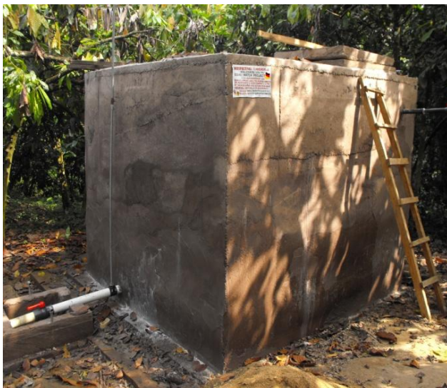
Beton Wassertank Nr. 1 mit Ventil und Ausgangsröhr richtung Dorf.
