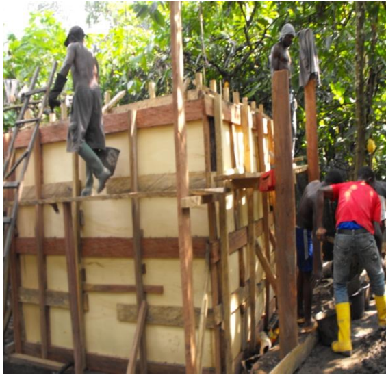
Wassertank Betonierung.
