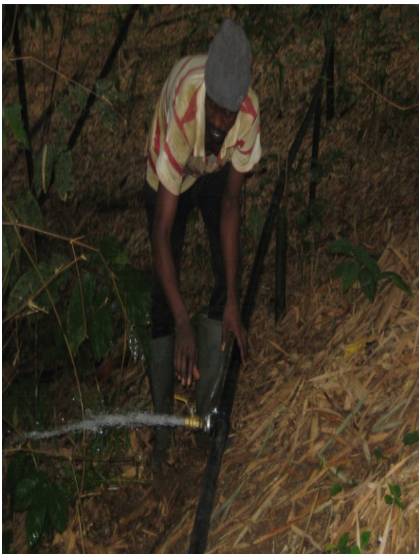
Luftabweichungventil in Zwischenabständen Instalirt.
