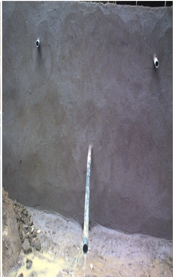
Betonierte Wasserquelle
